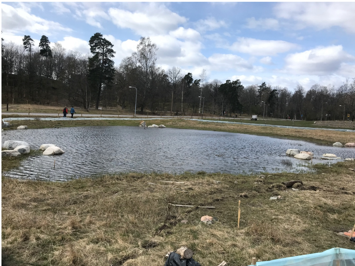
Figur 25. 2020-04-14 är vattenståndet 24 cm under bräddnivå. Den 18 mars var dammen fylld till bräddnivå.
